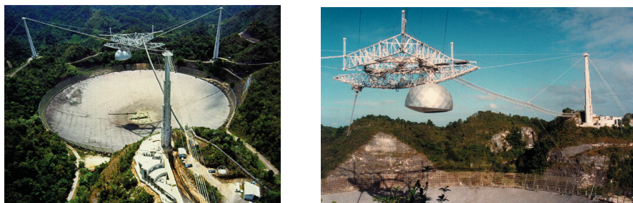
Рис. 23. Радиотелескоп Аресибо. Общий вид (слева). Подвижный облучатель (справа). Рисунок воспроизведен с сайта http://www.naic.edu
