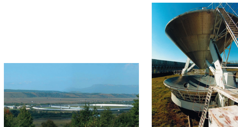
Рис. 20. Радиотелескоп РАТАН-600 (слева) и конический облучатель (справа). Рисунок воспроизведен с сайта http://www.sao.ru
