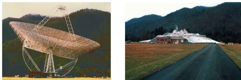
Рис. 25. 90,44-метровый радиотелескоп в Грин Бэнке (слева). Вид зеркала после 15 ноября 1988 г. (справа). Рисунок воспроизведен с сайта http://www.gb.nrao.edu
